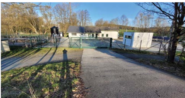
Abb. 1: Kläranlage Schlettau Gesamtblick
