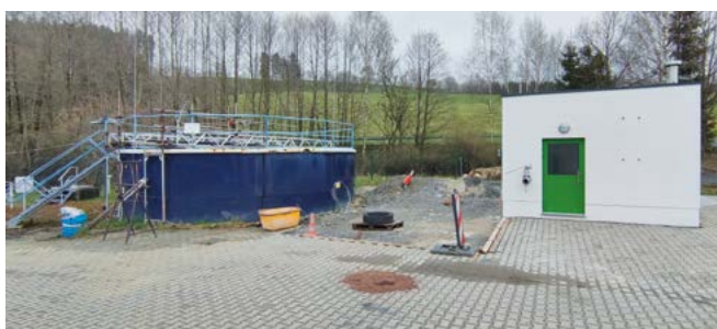
Abb. 9: Das fertige Pumpwerksgebäude
