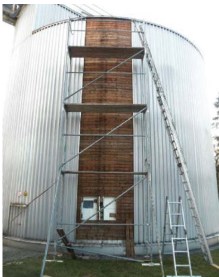
Abb. 1: Der Wandaufbau des Faulbehälter wird untersucht.
