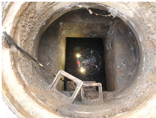
Abb. 4: Drohne fliegt im Schacht.
