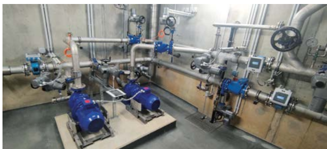
Abb. 10: Die trocken aufgestellten Kreiselpumpen
