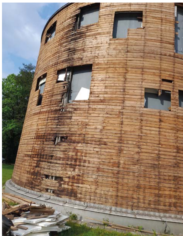
Abb. 3: Auch die Außendämmung musste zum Großteil demontiert werden.
