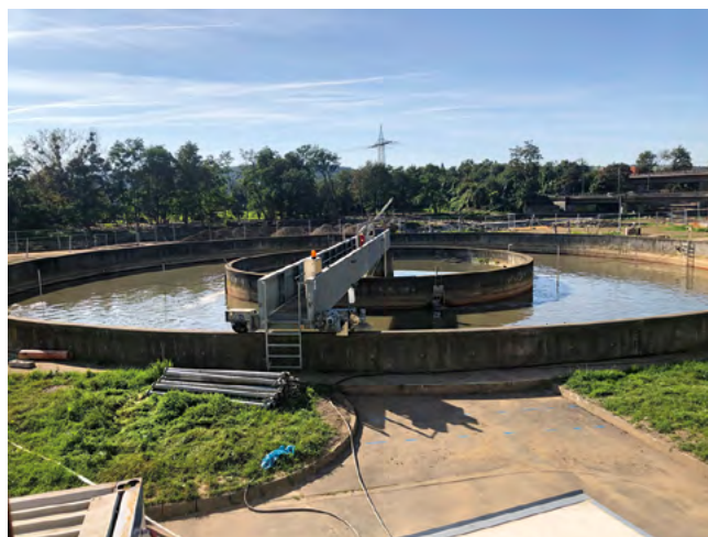
Abb. 10: Vorklärung und Denitrifikationsbecken nach Wiederinbetriebnahme (Foto: Caroline Götz)
