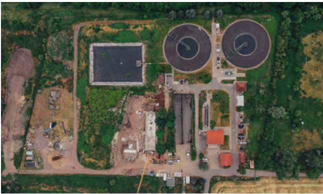
Abb. 1: Kläranlage Oschersleben von oben
