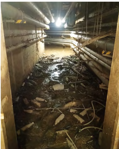
Abb. 8: Säuberung des begehbaren Rohrkanals (Foto: Marco Laux)
