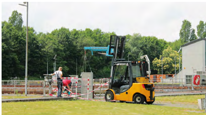
Abb. 2: Ziehen und Setzen des provisorischen Rechens mit einem Gabelstapler
