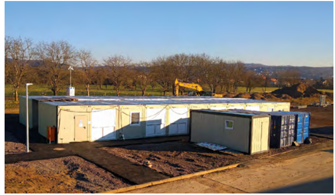
Abb. 12: Containeranlage mit Schwarz-Weiß-Umkleiden für Damen und Herren, Sozialraum, Besprechungsraum, Technikbüros, Toiletten und Labor (Foto: Marco Laux)
