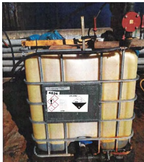
Abb. 3: Provisorische Eisenchlorid-Dosierung in den Schlamm-speicher (Foto: Stadtentwässerung Langenhagen)
