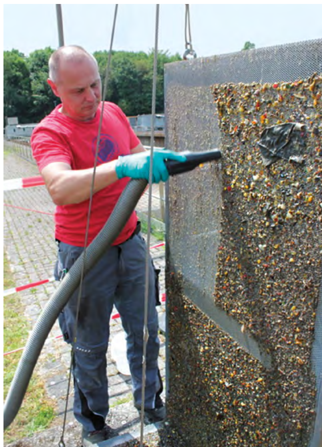
Abb. 3: Absaugung des belegten Rechens
