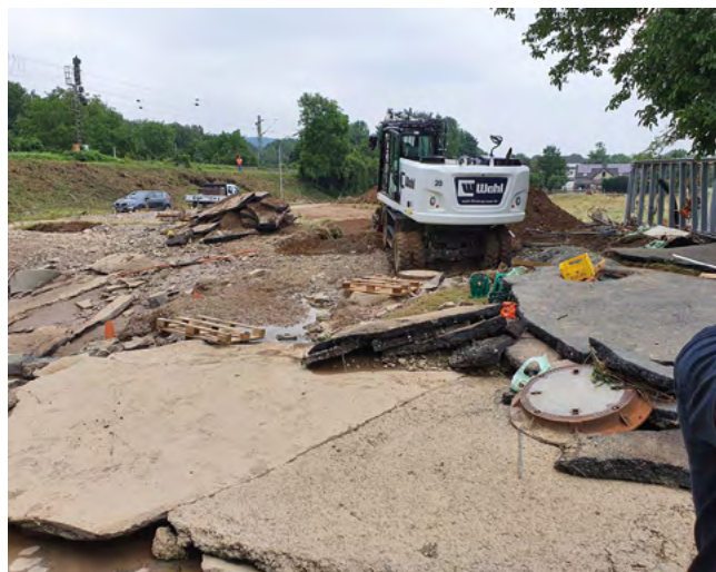
Abb. 5: Aufräumarbeiten: Die Flut riss ganze Asphaltdecken aus dem Boden – Herstellung einer Baustraße (Foto: Daniel Schwarz)
