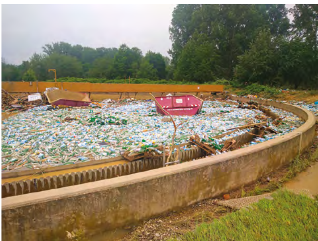
Abb. 4: PET-Flaschen im Nachklärbecken (Foto: Marco Laux)
