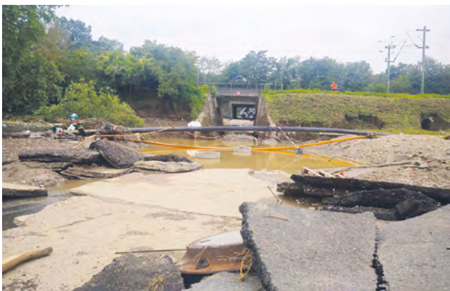
Abb. 3: Zufahrt zur Kläranlage (Foto: Marco Laux)
