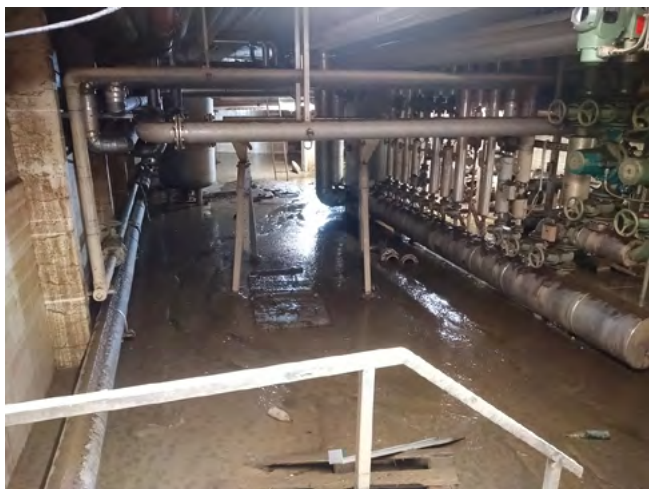
Abb. 6: Entleerung eines Kellers (Foto: Marco Laux)
