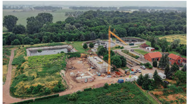
Abb. 2: Kläranlage Oschersleben – Sicht auf den Komplex der Klärschlammfaulung (im Bau)
