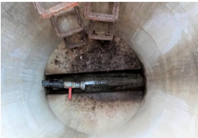
Abb. 2: Anschluss eines Kugelhahns mittels Plasson-Kupplung
