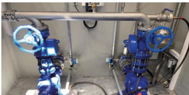
Abb. 5: Verschluss- und Anschlussmöglichkeit im Pumpwerk
