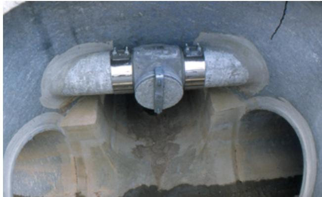
Abb. 6: Abzweigschacht mit innenliegendem Kabelzugrohr
