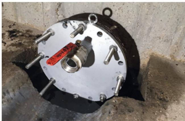
Abb. 3: Flanschplatte mit Durchgang am Rohrscheitel
