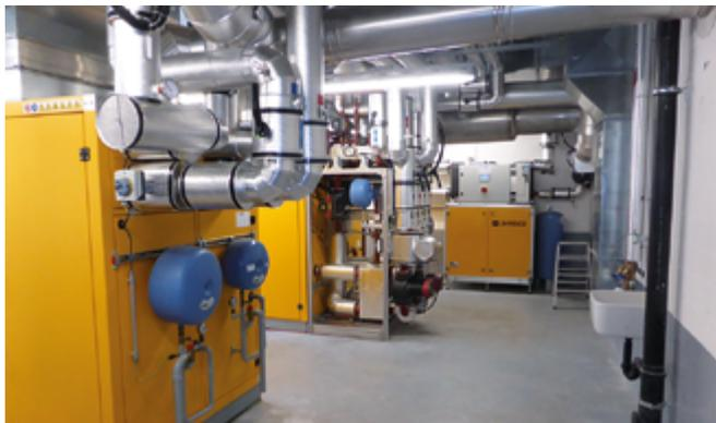
Abb. 3: Blockheizkraftwerke auf der ARA Hofen (Foto: Entsorgung St. Gallen)
