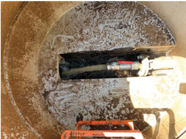
Abb. 1: Anschluss eines Kugelhahns mittels Flansch
