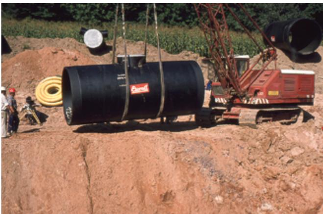
Abb. 5: Durchmesser 2000 mit vorgefertigtem Schachtanschluss
