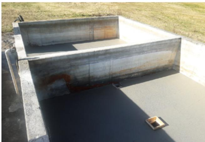
Abb. 2: Der Boden ist betoniert.
