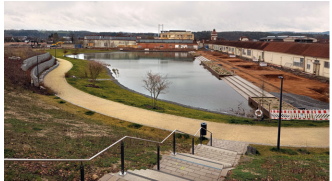
Abb. 2: Das Schwammstadt-Projekt ist fertig. Regenwasser wird gespeichert!
