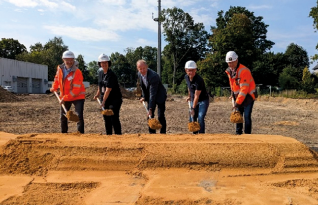
Abb. 2: Spatenstich des Großprojekts Umbau Zulaufbereich (v. l.): Marcus Kropp (Betriebsleiter ESC), Anne-Kathrin Sundheim (Abteilungsleiterin Kläranlage), Knut Kunze (Bürgermeister Stadt Chemnitz), Daniel Schneider (Hydro-Ingenieure), Dirk Möller (Implenia)
