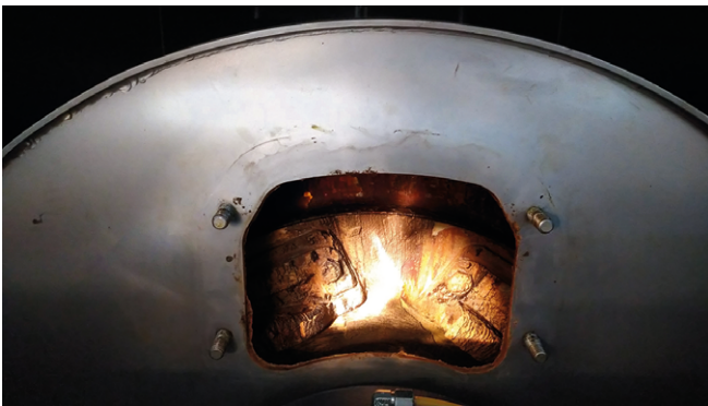
Abb. 7: Eine Inspektionsöffnung gewährt Einblicke in die Zentrifuge.
