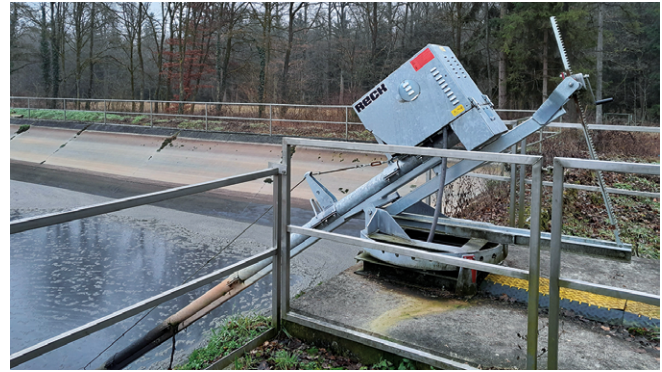
Abb. 6: Das zusätzliche Rührwerk kann die Sandablagerungen nicht verhindern
