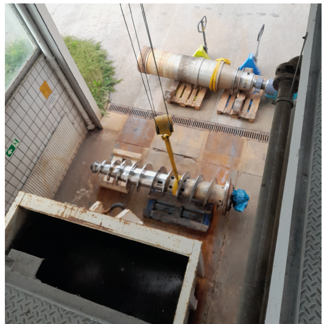
Abb. 13: Die reparierte Schnecke wird wieder angeliefert.
