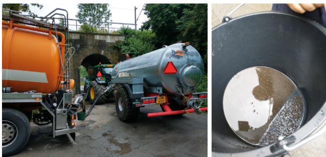
Abb. 2: Links: Anlieferung und Umfüllung des Impfschlammes, rechts: Stichprobe des Impfschlammes (Quelle: Ruhrverband)
