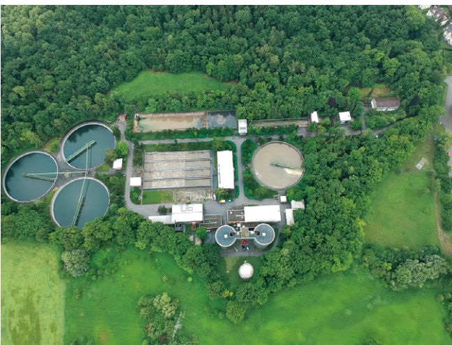
Abb. 1: Luftbild der Kläranlage
