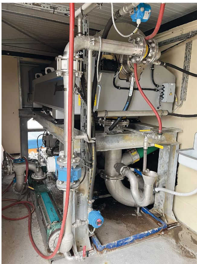
Abb. 5: Absaugung der Zentrifuge
