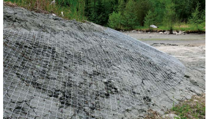
Abb. 9: Gitterauflage auf einem Damm als Schutz gegen Unterminierung
