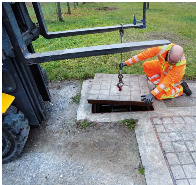
Abb. 2: Öffnen der bestehenden Abdeckungen
