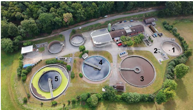
Abb. 1: Die Kläranlage Mühlbachtal (1: Regenüberlaufbecken; 2: Feinsiebzanlage; 3: Belebungsbecken; 4 Nachklärbecken; 5: Belebungs-Nachklär-Kombibecken)
