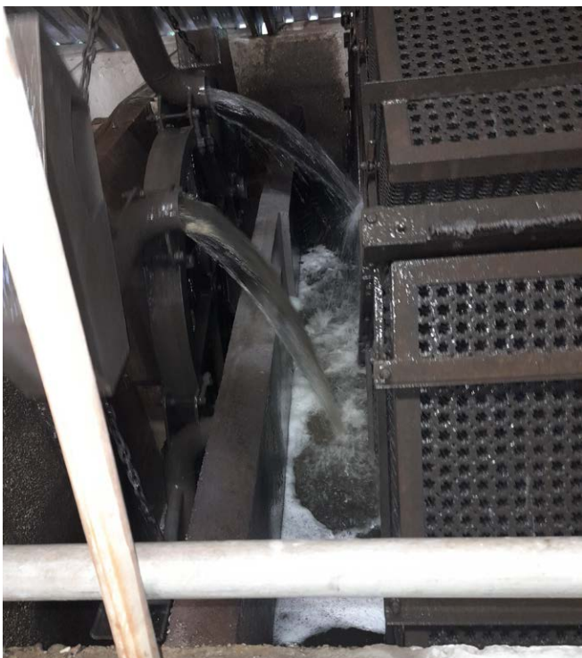
Abb. 3: Schöpfrad mit Schaumbildung zum Tauchtropfkörper
