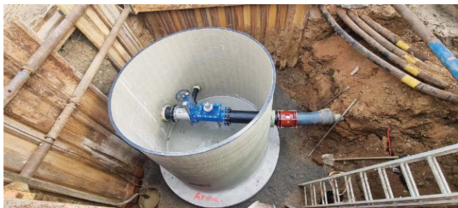
Abb. 3: Armaturenschacht im Einbau
