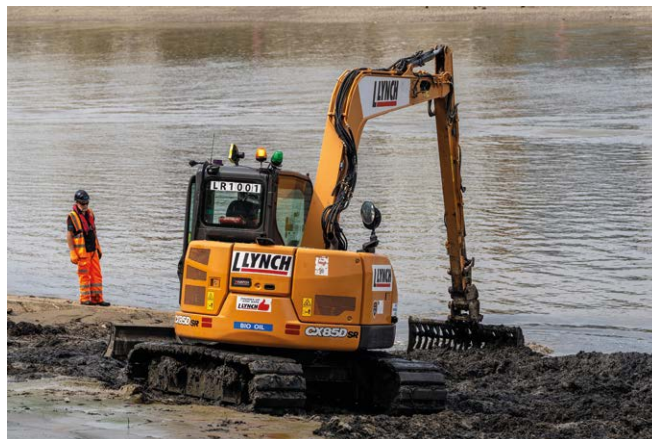
Abb. 2: Abaggern von Wet Wipe Island am Themse-Ufer im Westen Londons (Foto: Thames Water/Port of London Authority)
