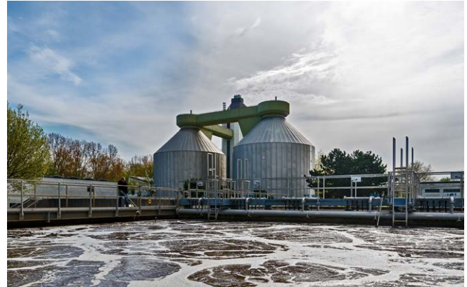
Abb. 1: Die Faulbehälter der Kläranlage Köln-Langel
