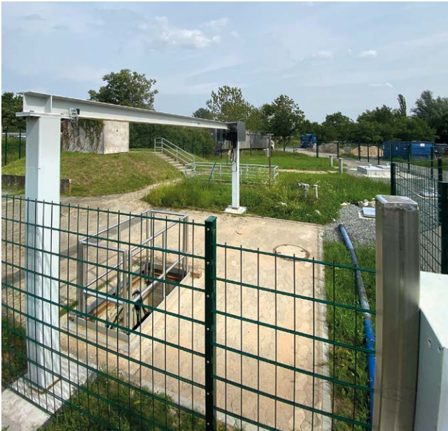
Abb. 6: Fertige Außenanlagen mit Kranportal
