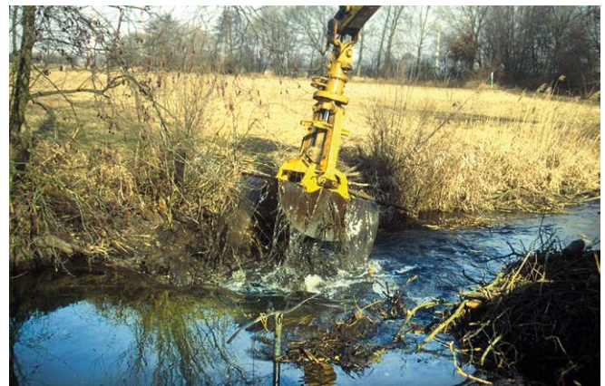
Abb. 10: Herausbaggern eines größeren Biberdamms. Beim Verlegen wird das Material oberhalb wieder eingebracht.
