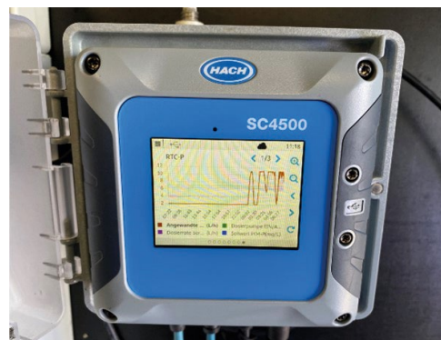
Abb. 4: Der Messumformer bündelt die Signale und beherbergt die Regler.
