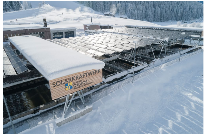
Abb. 2a: Das Solarfaltdach produziert Strom auch im Winter.
