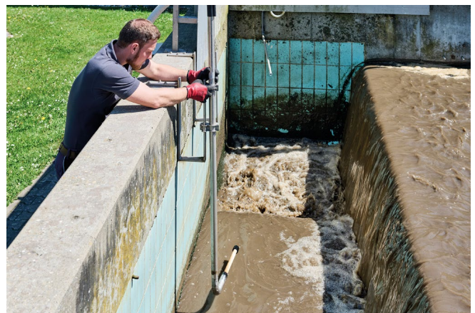
Abb. 2a: Die Probenahme mit integrierter Filtration wird zu Wartungszwecken aus dem Ablaufgerinne der beiden Belebungsbeckenstraßen gezogen.
