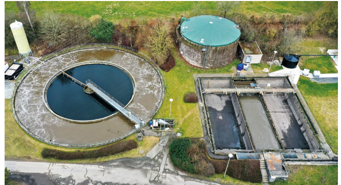
Abb. 1: Kläranlage Hachenburg. Rechteckbecken mit mittig angeordneter Vorklärung und seitlichen Regenüberlaufbecken, Belebungsanlage als rundes Kombibecken und das separate Misch- und Ausgleichsbecken mit grüner Abdeckung im Hintergrund
