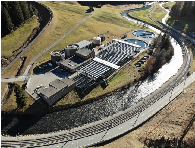
Abb. 1: Luftbild der Kläranlage Davos mit aufgespanntem Solarfaltdach
