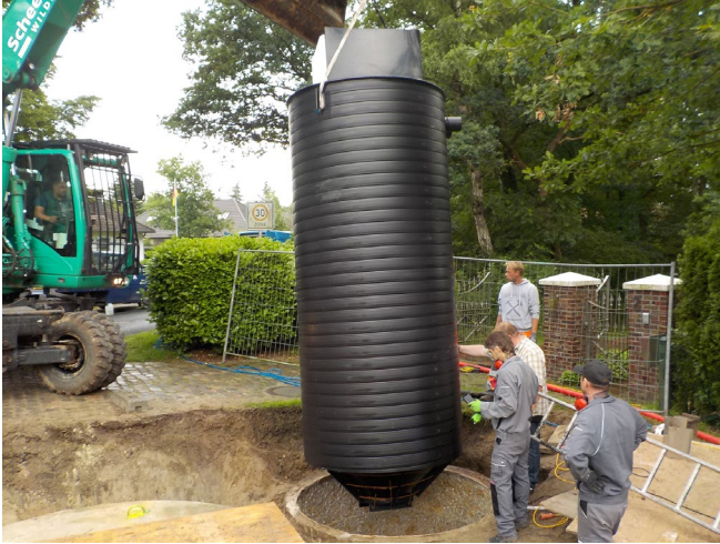
Abb. 4: Einbau eines PE-Fertigschachts
