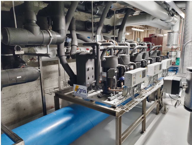
Abb. 5: Die Wärmepumpe unterstützt die Wärmeversorgung der Faulbehälter.
