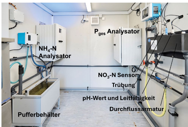
Abb. 8: Ein Blick ins Innere des Messcontainers mit dem Pufferbehälter und zwei Analysatoren sowie einem Analysepanel (rechts im Bild) mit schwarzer Durchflussarmatur und eingebauten Sensoren
