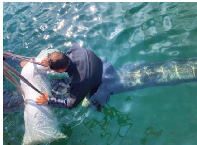
Abb. 5: Einer der vier Berufstaucher bei der Vorbereitung zum Absenken der aufgeschwommenen Abwasserleitung durch Sandbetonsäcke
