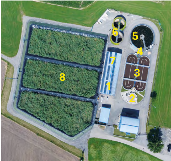
Abb. 1: Luftbild der Kläranlage Polling: (1) Rechen, Sand- und Fettfang, (2) Anaerobbecken, (3) Belebungsbecken, (4) Nachbelüftungsschacht, (5) Nachklärbecken, (6) Schlamm-silo, (7) Maschinen- und Schlammgebäude, (8) Schilfbeete für die Vererdung (Foto: RHV Polling)
