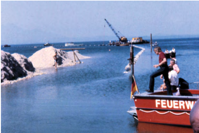
Abb. 3: Die Leitung schwimmt (Foto Hannes Felber)
