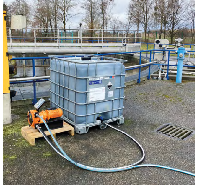
Abb. 2: Dosierung über IBC (Foto: Donau Chemie AG)
