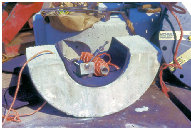
Abb. 1: Vorbereiten der Halbschalen aus Beton (Foto am 16.07.1986, Hannes Felber)
