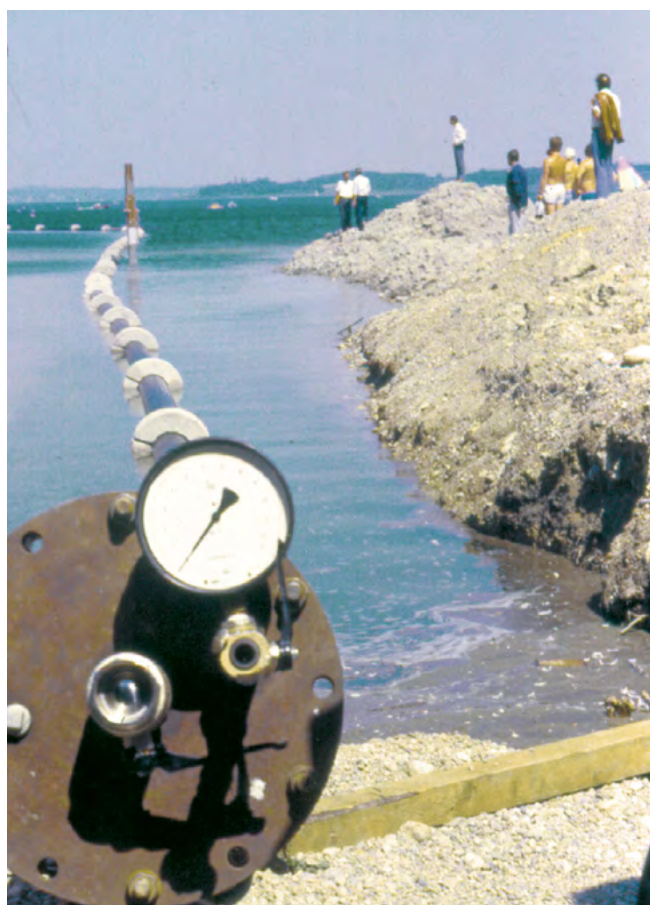
Abb. 2: Vor Ort Verschweißen und Prüfen der Rohrverbindung (Foto: Hannes Felber)
