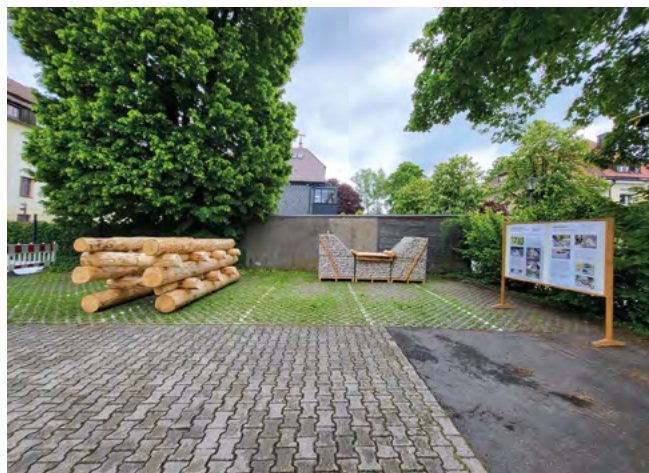
Abb. 2: Mächtige Bollwerke gegen Geschiebe sind Holzkastensperren (links) und Gabionensperren (rechts), die in Wildbächen verbaut werden (Foto WWA Traunstein)
