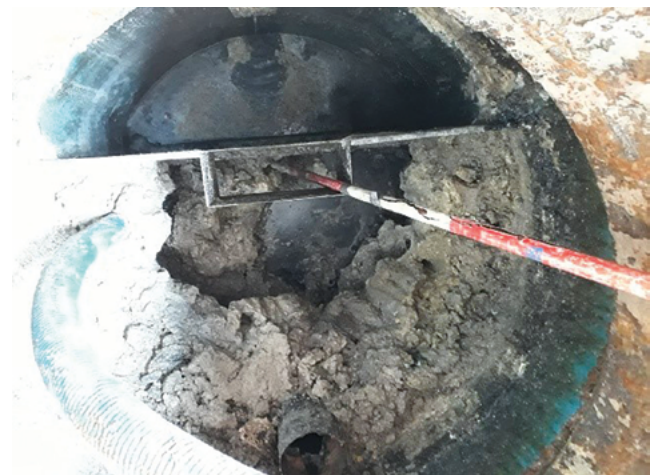
Abb. 1: Blick in einen vernachlässigten Fettabscheider (Quelle: Masterarbeit Klaus Jilg)
