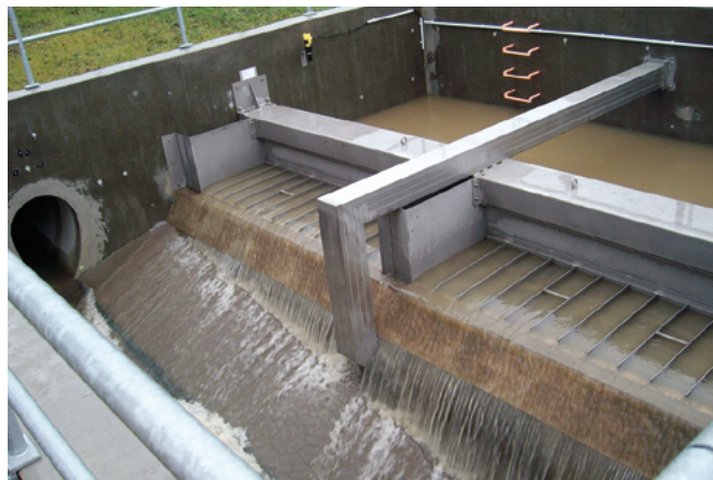
Abb. 1: Eine Siebanlage im Betrieb
