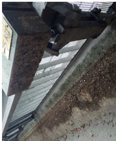
Abb. 2: Die Siebrostfläche von unten und die Reinigungsbürste (links hinten und oben, mit teilweise sichtbarem Gegengewicht). Auf eine ausreichende Zugänglichkeit unter dem Siebrost ist zu achten.
