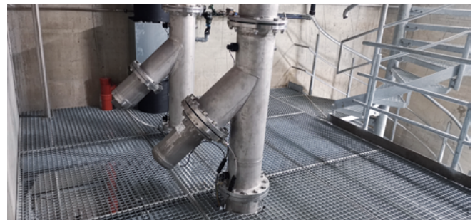
Abb. 3: Zwei in den Druckleitungen der Grundlastpumpen im Hauptpumpwerk des Abwasserwerkes Greifswald installierte Dämpfungssysteme
