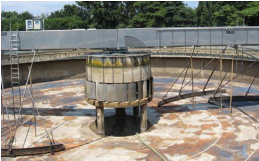
Abb. 7a: Einlaufbauwerk NKB 2 Bestand
