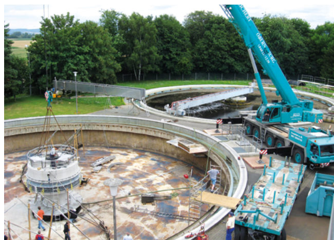
Abb. 6: Montage des neuen Einlaufbauwerks im NKB 2
