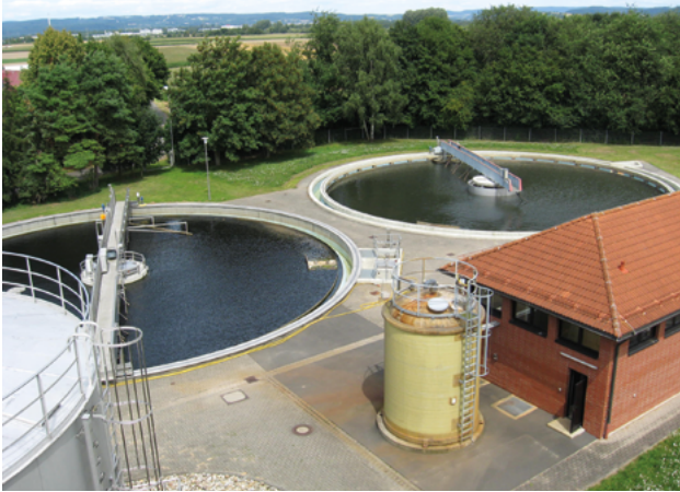
Abb. 13: Beide Nachklärbecken nach Ertüchtigung wieder in Betrieb
